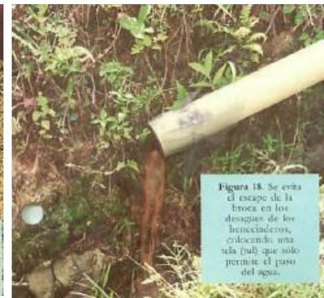
Figura 18. Se evita el escape de la broca en los desague de los beneficiaderos, colocando una tela (tul) que solo permite el paso del agua.
